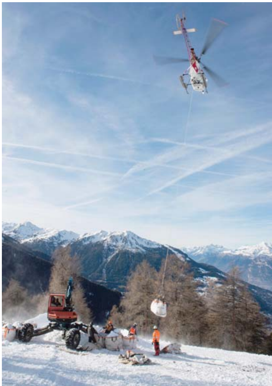
Transport de neige générée par des canons, au sommet des pistes, vers le départ des télécabines.
